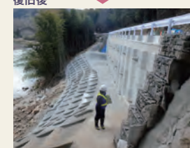
復旧後 宮城県丸森町地区の災害復旧状況
