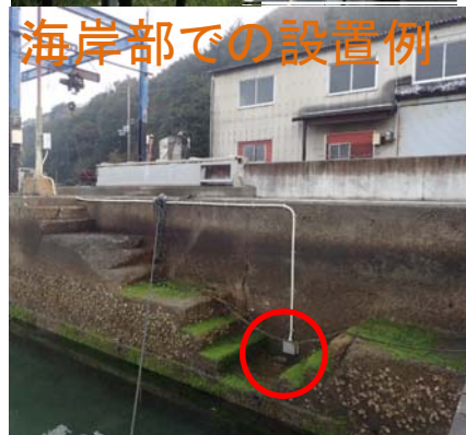
センサーが水没した際に受ける水圧から水深を計測 ※赤丸がセンサー部
