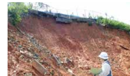
北九州市内の斜面崩壊現場での現地調査の様子
